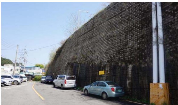
< 고가도로 하부 옹벽 >
