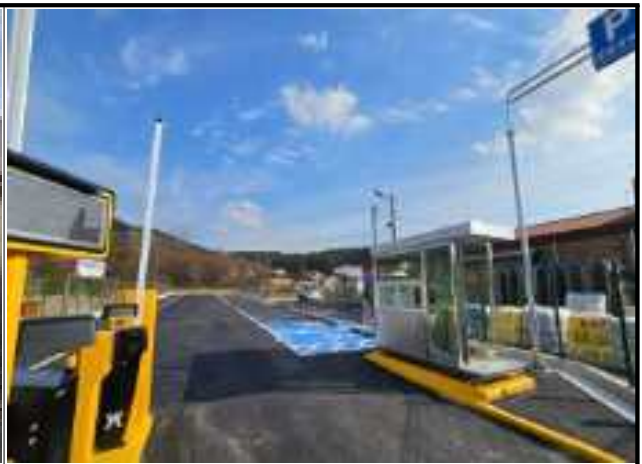
두구동 수내 공영주차장 조성공사
