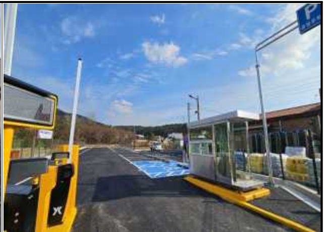
두구동 수내 공영주차장 조성공사
