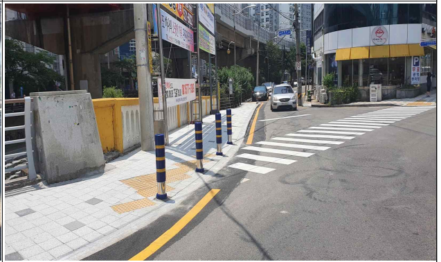
구서온천천로 일원 보행환경 개선공사 후
