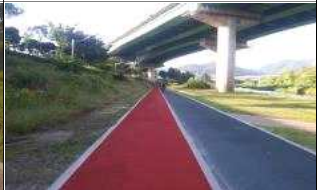
수영강 자전거도로 정비공사 후
