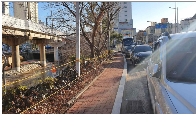
구서온천천로 일원 보행환경 개선공사 전
