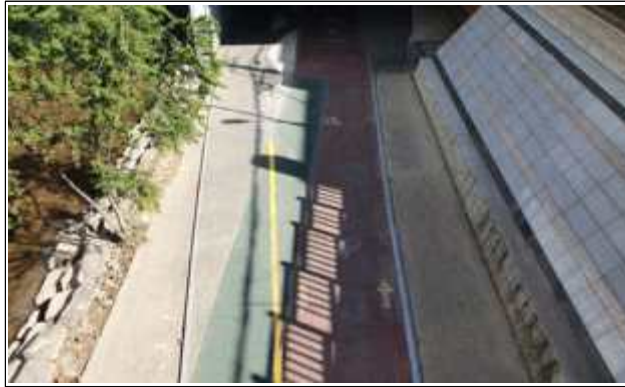
온천천 자전거도로 정비공사 전
