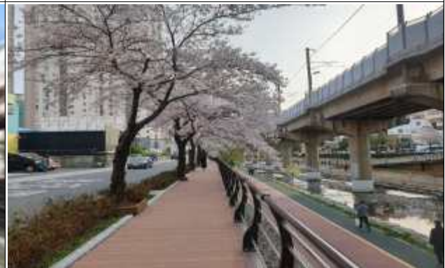
부곡온천천로 일원 보행환경정비공사 공사 후
