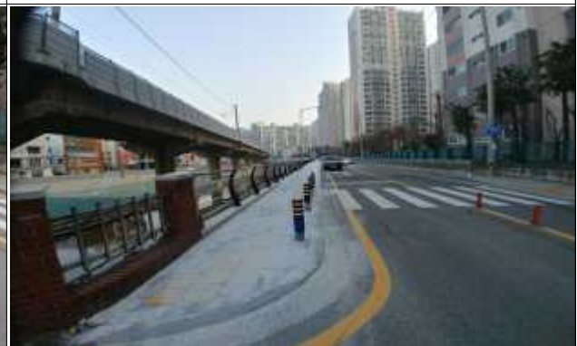
부산대역~장전역간 보도정비공사 공사 후
