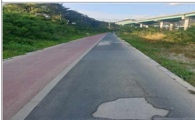
수영강 하류 산책로 정비공사 전
