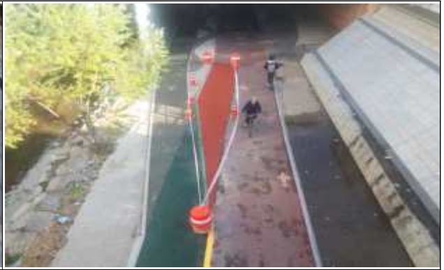
온천천 자전거도로 정비공사 후
