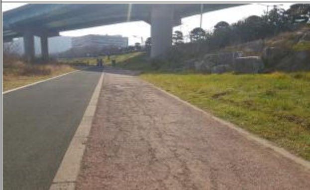
수영강 자전거도로 정비공사 전
