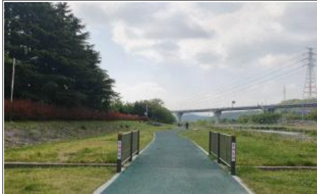
수영강 한물교~신천교 간 산책로 정비공사 전
