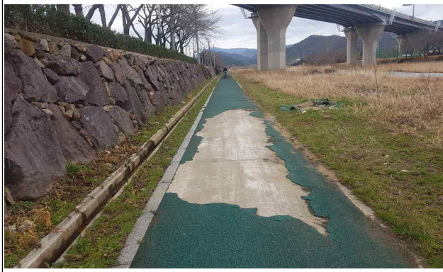
수영강 상류 우안 산책로 정비공사 전
