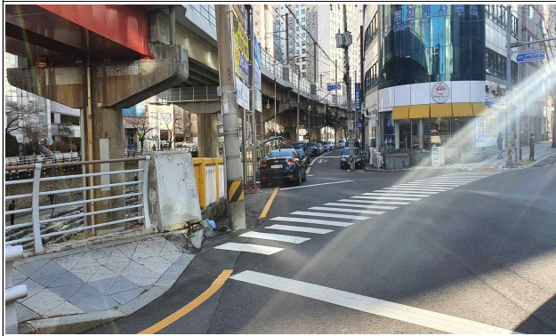
구서온천천로 일원 보행환경 개선공사 전
