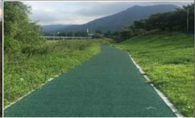
수영강 한물교~두구교 간 산책로 정비공사 후
