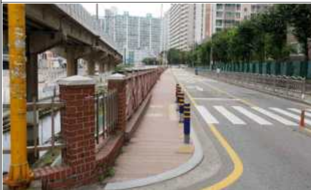
부산대역~장전역간 보도정비공사 공사 전
