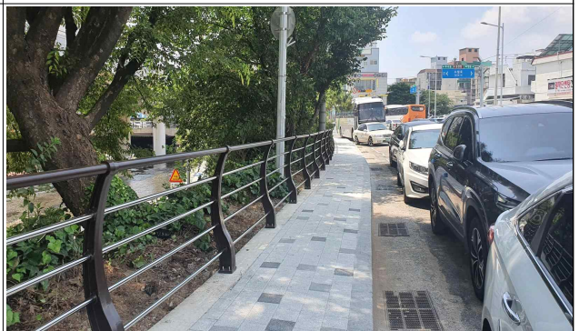
구서온천천로 일원 보행환경 개선공사 후
