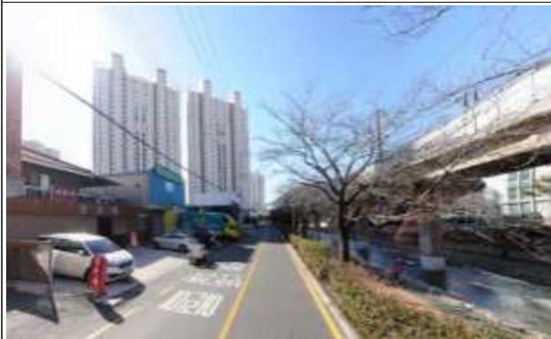
부곡온천천로 일원 보행환경정비공사 공사 전
