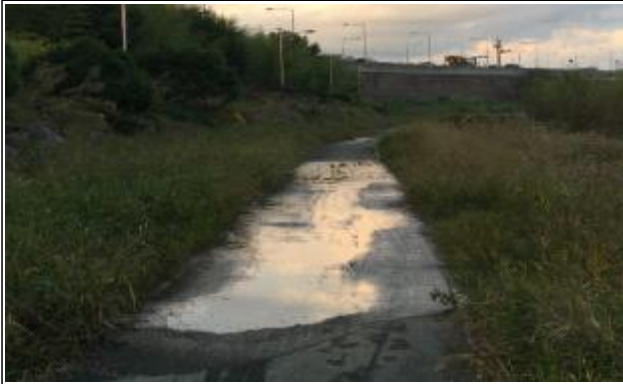
수영강 한물교~두구교 간 산책로 정비공사 전
