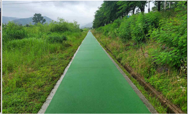
수영강 상류 우안 산책로 정비공사 후
