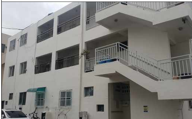
2019년 공동주택 관리 지원 사업(외벽도색 공사)
