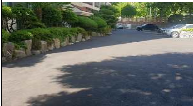
2019년 공동주택 관리 지원 사업(단지 내 도로포장 공사)
