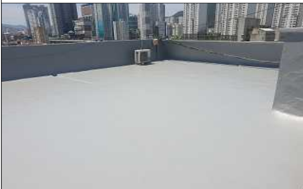
2020년 공동주택 관리 지원 사업(옥상방수 공사)
