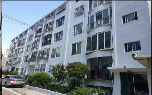
2020년 공동주택 관리 지원 사업(외벽도색 공사)
