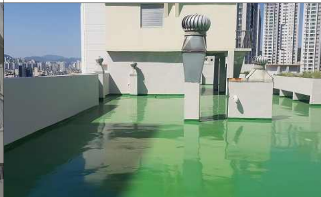
2019년 공동주택 관리 지원 사업(옥상방수 공사)
