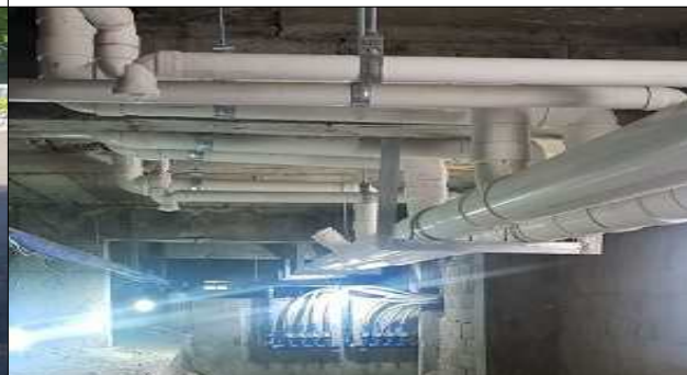
2019년 공동주택 관리 지원 사업(오·배수관 교체 공사)
