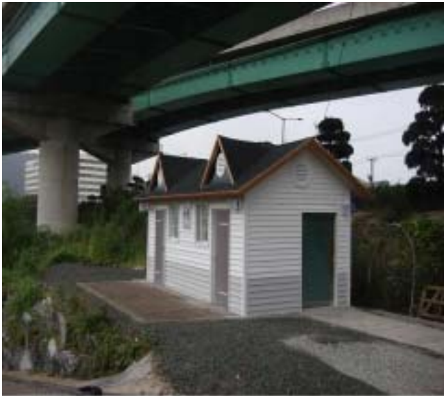
회동동 수영장변 공중화장실
