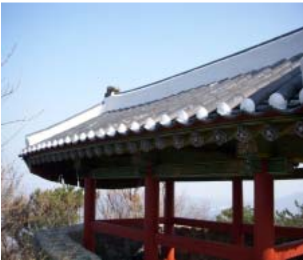
【2망루 지붕 및 기둥보수】
