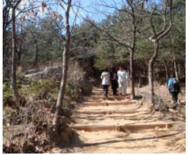
북문~범어사간 목재계단 설치
