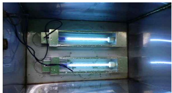
<그림 21> 약수터 자외선 살균기 설치
