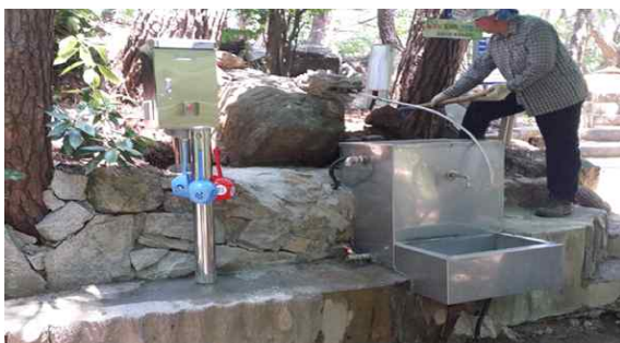
<그림 21> 약수터 자외선 살균기 설치
