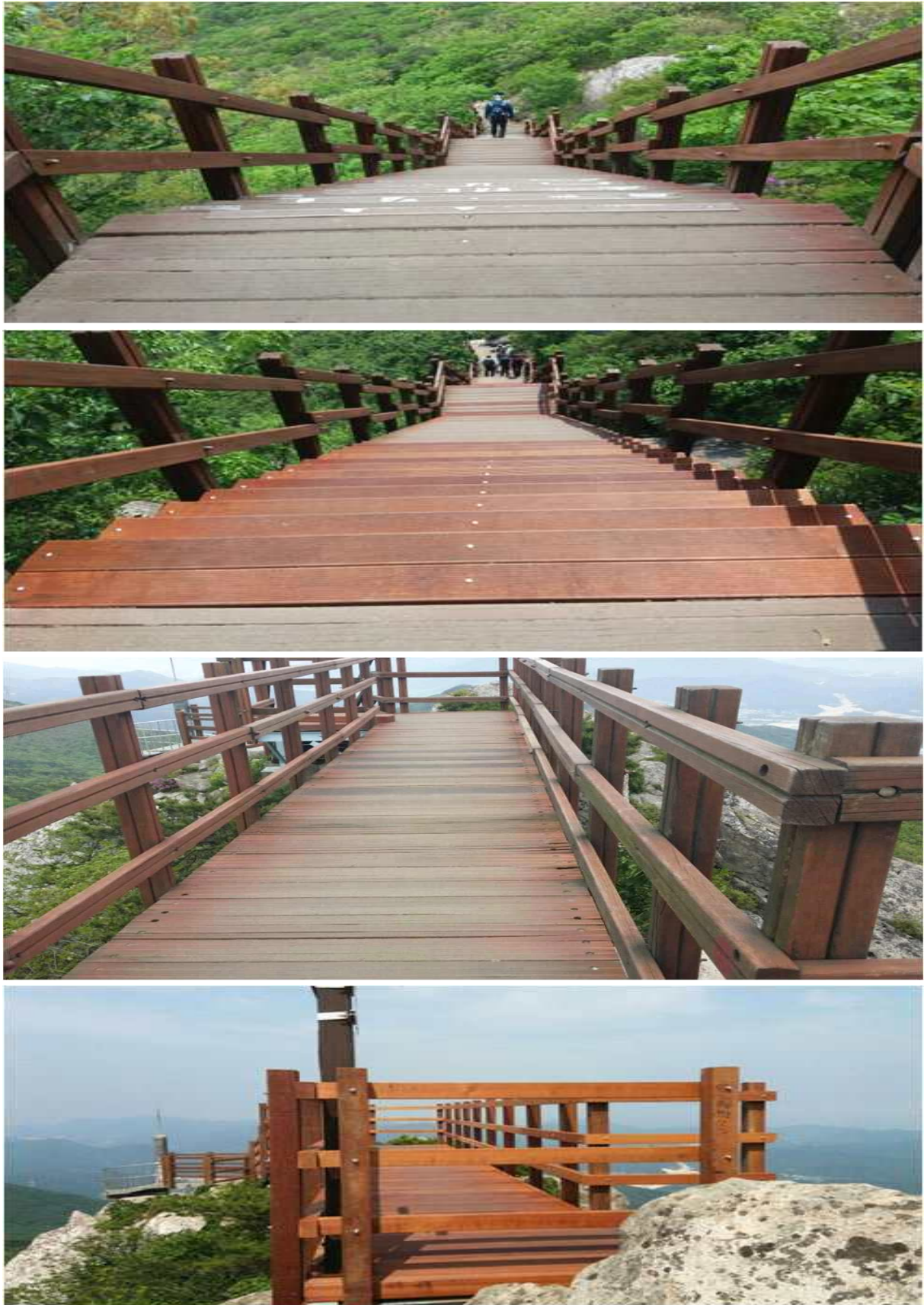
<그림 25> 고당봉 지구 판재 및 난간 교체 전·후
